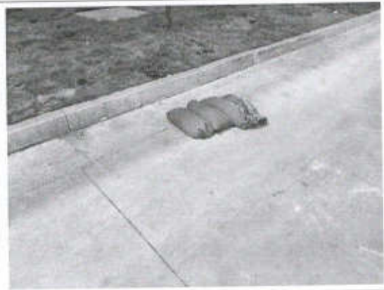
消防沙袋堵住雨水口
